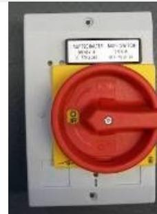
3. Den roten Drehknopf anschrauben und Hinweisschilder auf Vorder- und Rückseite montieren.
