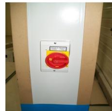
12. Anschließend die Blende auf den Einbaurahmen aufsetzen und festschrauben.
