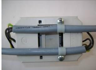
8. Kabel nach hinten um den Einbaurahmen legen und mit den Kabelschellen befestigen
