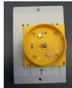
2. Die Blende des Einbaurahmens an den Schalter anschrauben. Dies erfolgt über die gelbe Montageplatte des Hauptschalters. Verwenden Sie dazu die markierten Löcher (2) in der Blende. Das Glöckner Möller Logo (1) dient als Orientierungshilfe.
